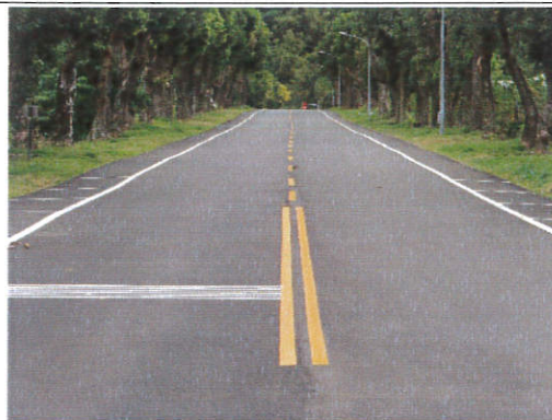
機關內通行道路
