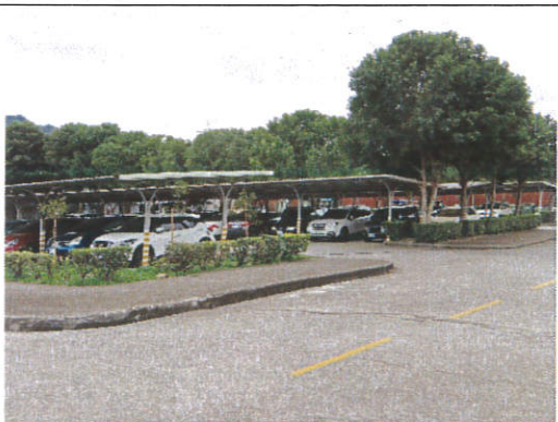
機關內車場及遮雨棚現況
