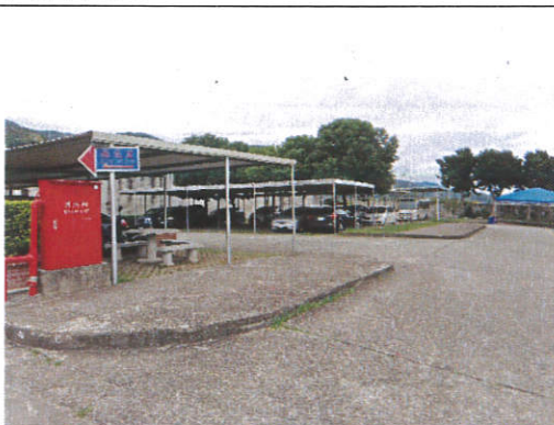
機關內車場及遮雨棚現況
