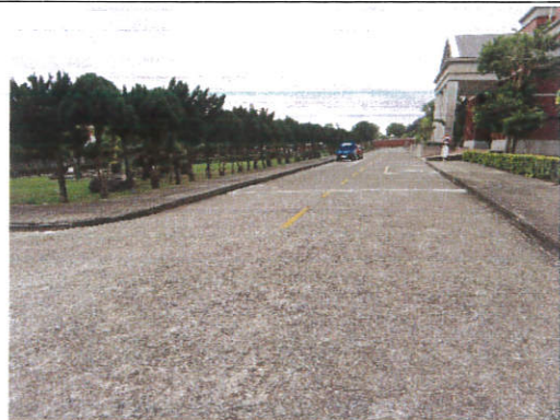
機關內通行道路
